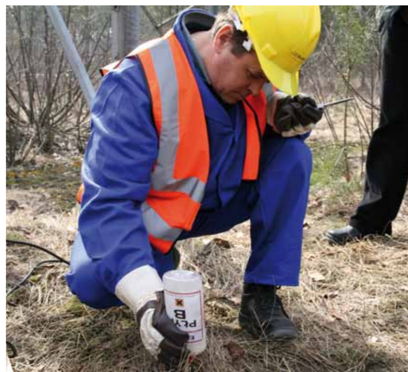
Sposób podawania substancji polepszających (płynów „A” i „B”)
