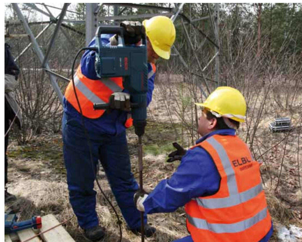
Sposób pogrążania uziomu DO-EL
