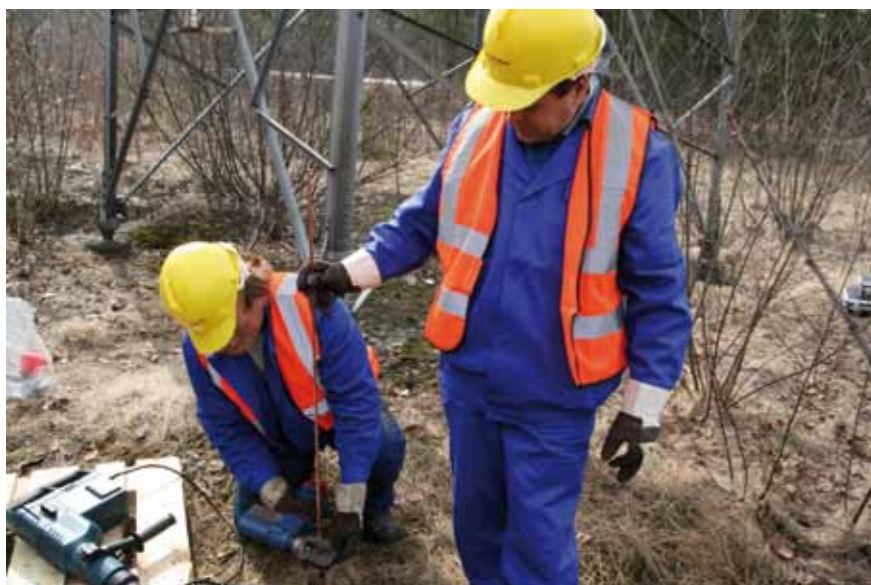
Sposób łączenia prętów miedzianych (uziomu właściwego)
